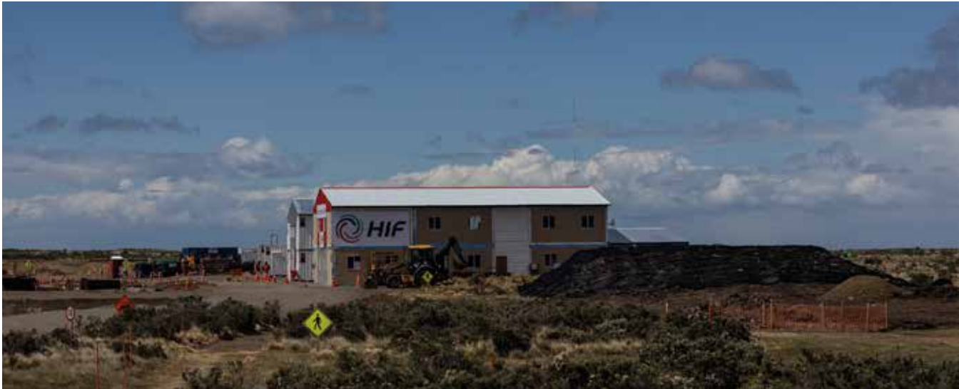
Die Bundesregierung und deutsche Unternehmen erhoffen sich preiswerten grünen Wasserstoff aus Chile. Das Projekt „Haru Oni“ des Konsortiums HIF produziert synthetische Kraftstoffe für Porsche. Foto: Sofia Yanjari.
