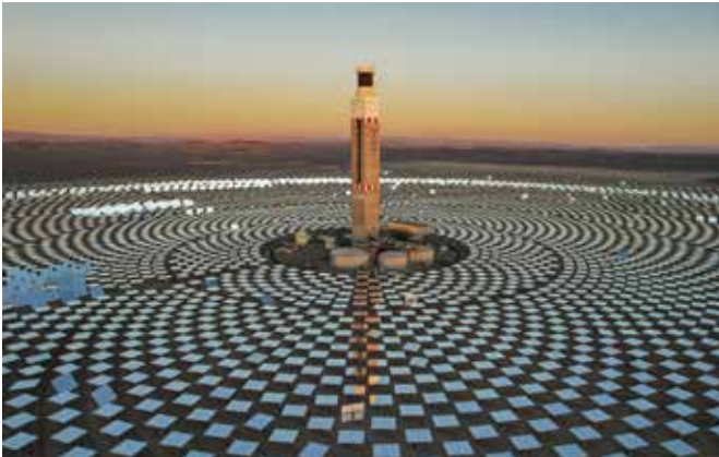
Das Solarkraftwerk 'Cerro Dominador' in der Atacama Wüste mit einer Leistung von 110 MW. Foto: IMF Photo/Tamara Merino, CC BY-NC-ND 2.0.
