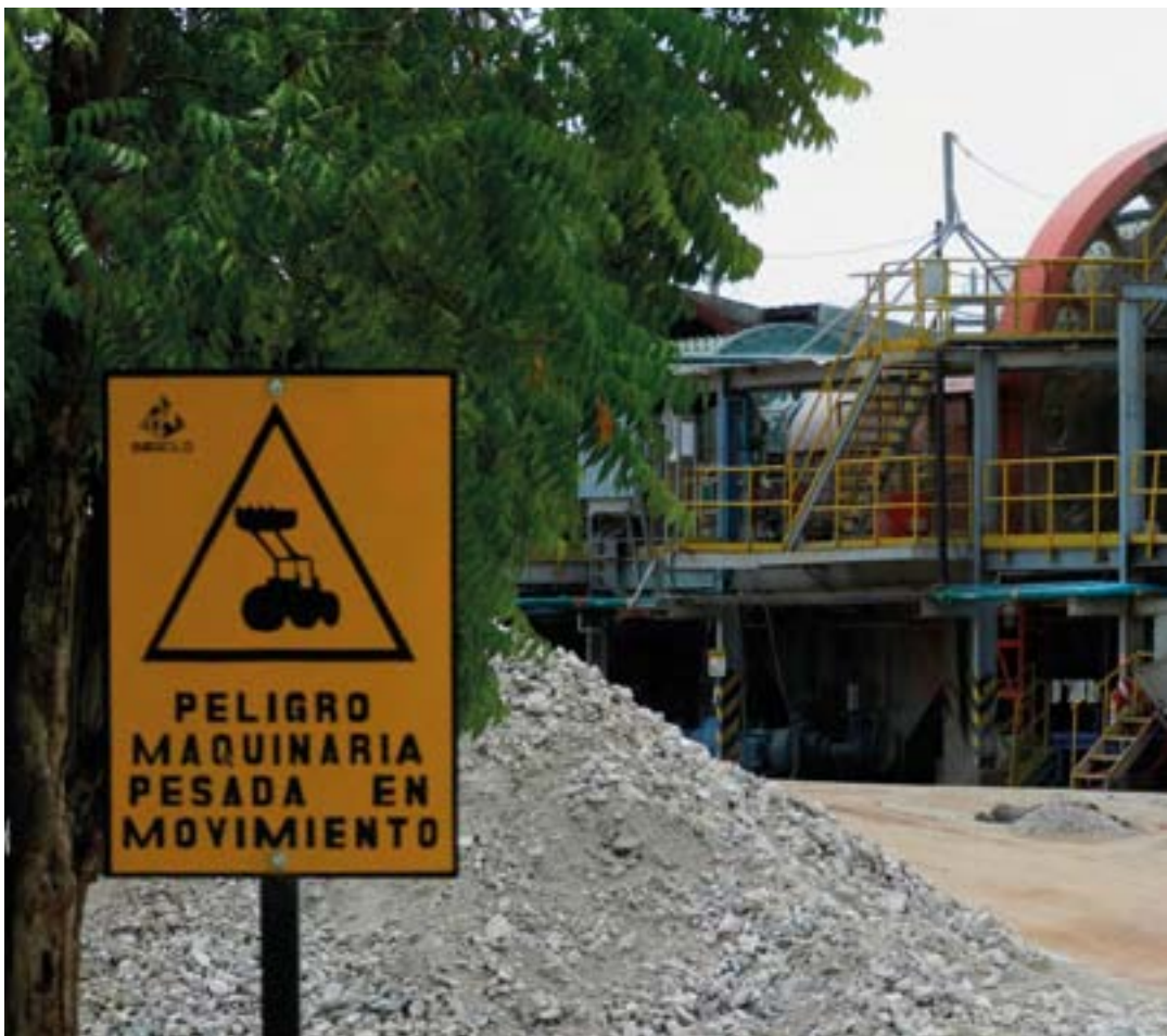
Goldverarbeitungsanlage Mine El Limón/Nicaragua; Quelle: Steffi Wassermann
