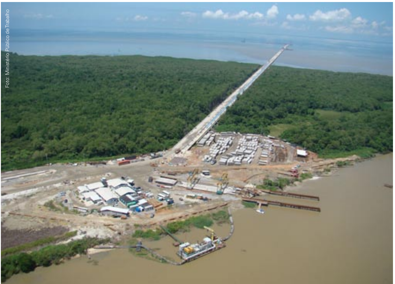
▼ Zerstörung von Mangrovenwäldern für TKCSA Der Pier des Stahlwerks während der Bauphase 2008
