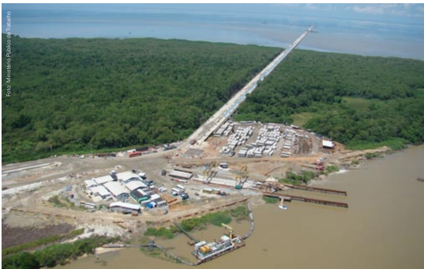
▼ Destrucción de manglares por TKCSA El embarcadero de la planta de acero durante la fase de construcción en 2008
